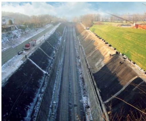
Figura 48- Esempio di applicazione della geostuoia antierosiva polimerica tipo Macmat R Polimeric, durante la fase di messa in opera e in seguito al rinverdimento
