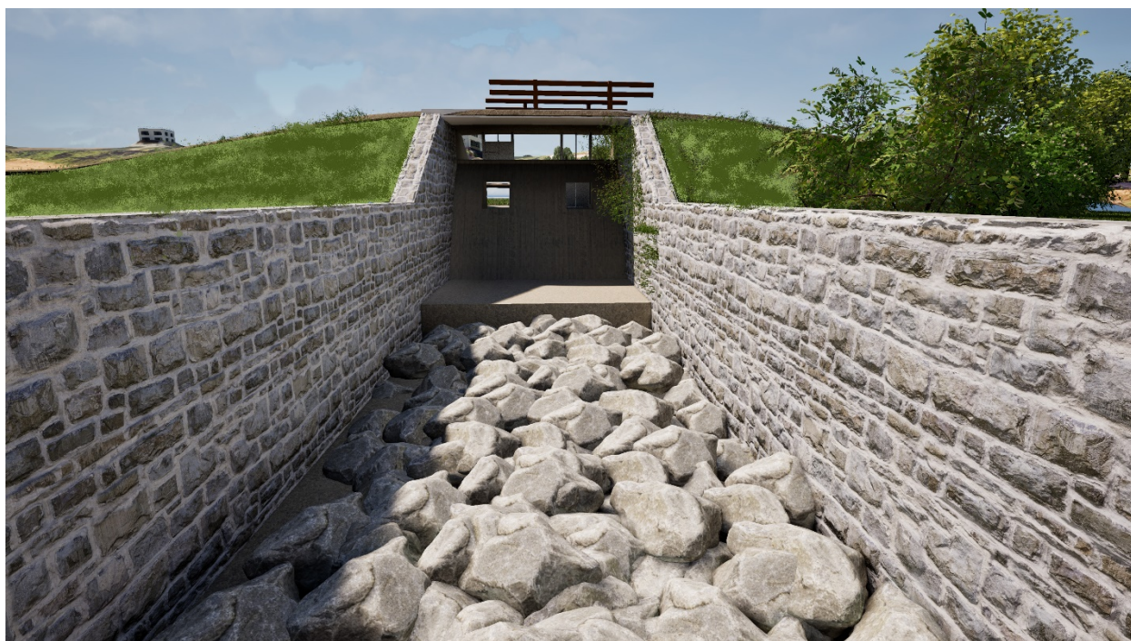
Figura 60 – Vista manufatto di restituzione (lato valle). Fondo con massi ciclopici; pareti laterali con rivestimento in pietra naturale
